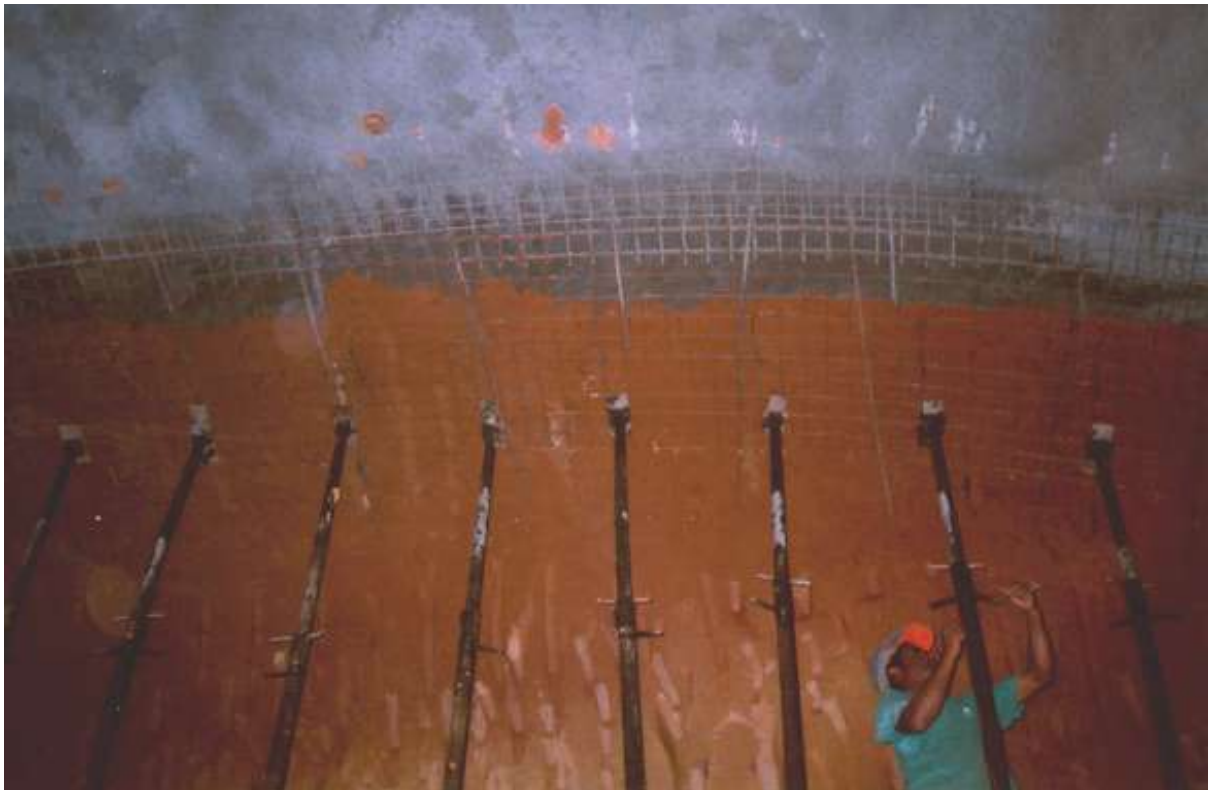
Figura 25 – Escoramento do revestimento de teto, seqüenciada ao avanço da escavação do túnel
