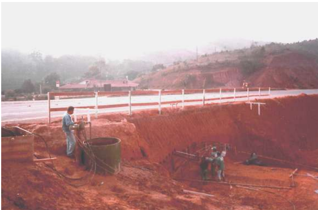
Figura 18 - Execução de furos de enfilagem para a consolidação do maciço
