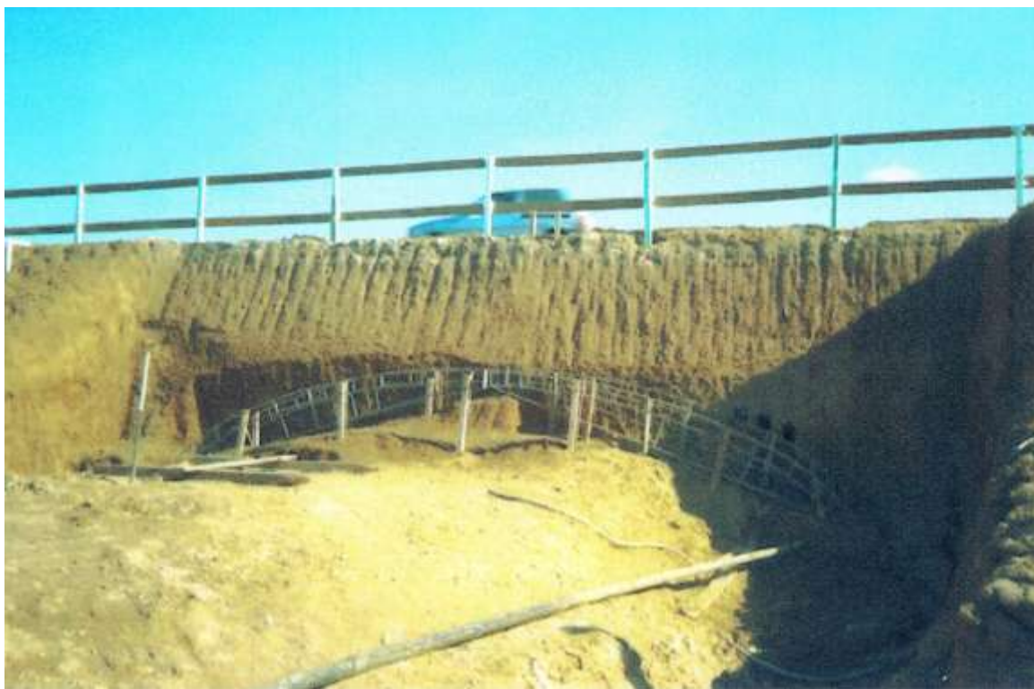
Figura 22 – Montagem de gabaritos para a instalação do processo de enfilagem.
